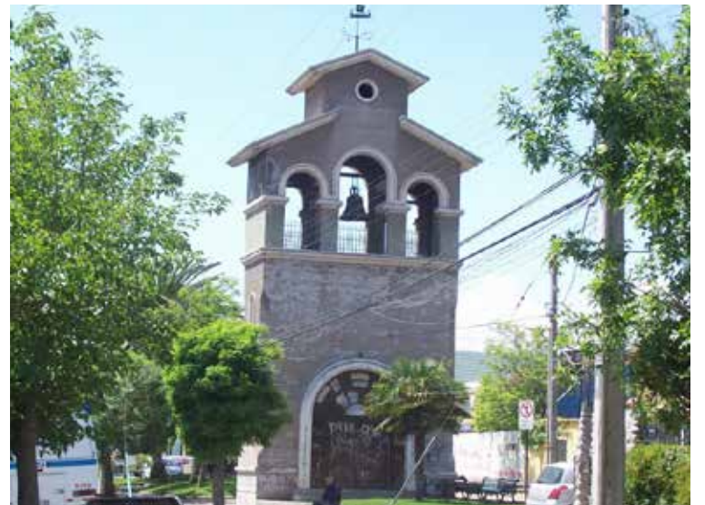
Tras su demolición la construcción de este campanario es el único testimonio de este templo religioso.
