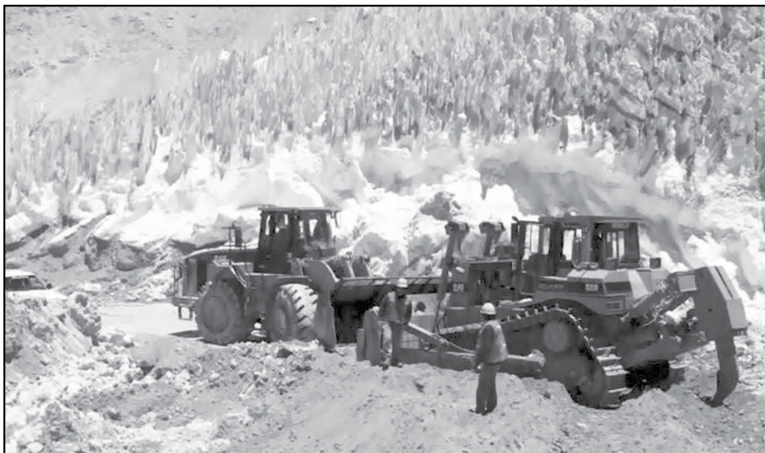
Maquinarias: un cargador frontal y una retroexcavadora construyen un acceso donde se encuentran los actuales glaciares, proyecto minero que pondrá en peligro el regadío de 15 mil Ha en los valles de Aconcagua y Quillota.
