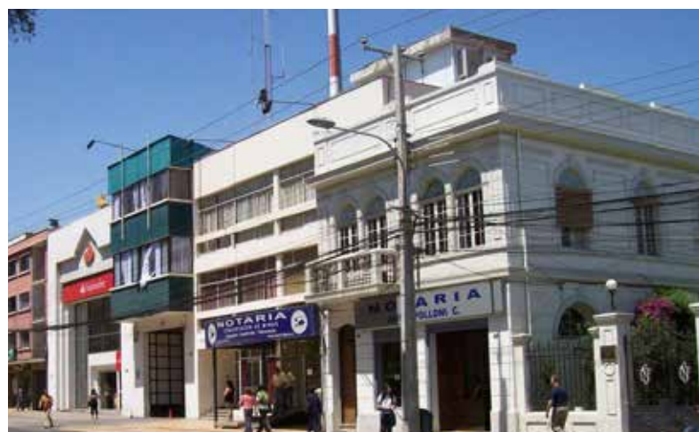
Edificio de estilo modernista, implantado por el M.O.P. después del terremoto de 1965, modelo aplicado en gran parte del país.
