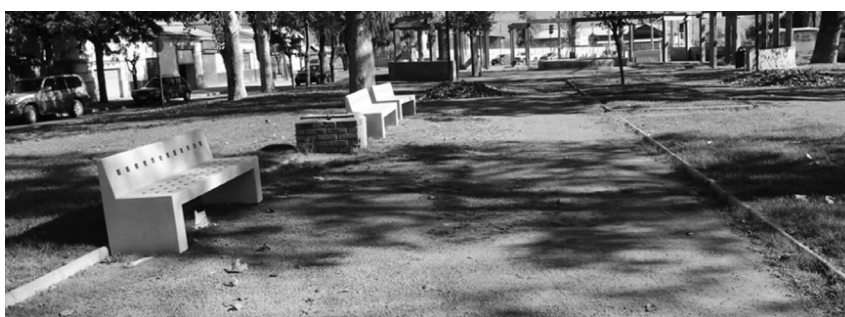
En la imagen se aprecia la instalación de los primeros escaños antivandálicos. Concluido este proceso se instalarán las luminarias led.
