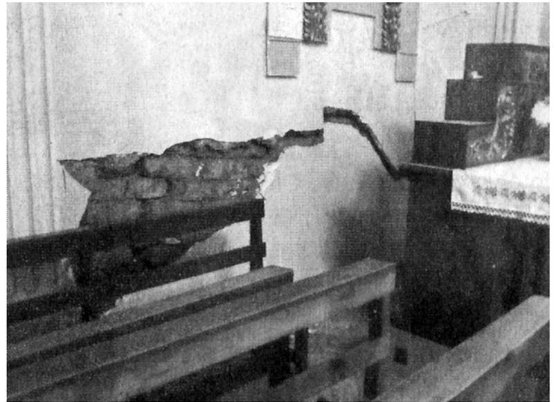
*Grietas que terminaron por minar la estructura de la Iglesia del Buen Pastor, fue la que causó el terremoto del año 2010, obligando a los ingenieros a instalar una cadena de hormigón en el techo y exoesqueletos de madera y malla en sus muros.*
