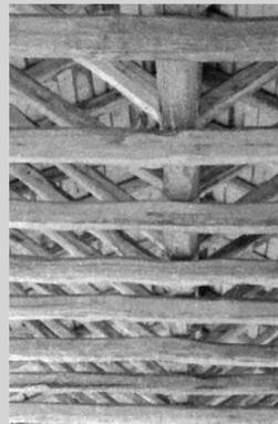
La madera es el material más apropiado -sobre todo el álamo, y mejor si es azuelado a mano con hacha- para construir soleras, vigas y tijerales. Este material resiste a la tracción, y el adobe, en cambio, a la compresión. Juntos, entonces, trabajan de manera antisísmica.
