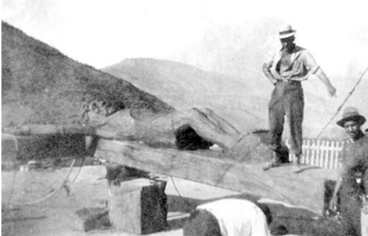
Peter Horn, escultor alemán sobre el madero aún en el suelo dirigiendo la obra para ser levantado, año 1935.
