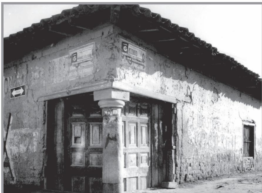
Antiguo pilar de esquina cuya construcción se remonta a 1950, se sitúa entre las actuales vías Encón esquina Sargento Aldea. En la actualidad funciona la Escuela José Antonio Manso de Velasco.
